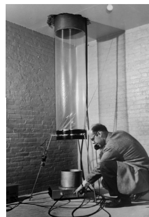
■ Figura 13.52 Rebka trabajando en el sótano del laboratorio Jefferson, en Harvard; el tubo de polietileno contiene helio, que sirve para enfocar los fotones gamma en un haz estrecho
